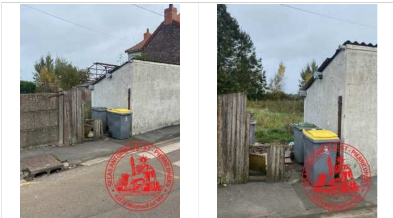
A cet endroit l'ensemble est à l'état d'abandon, non entretenu.
